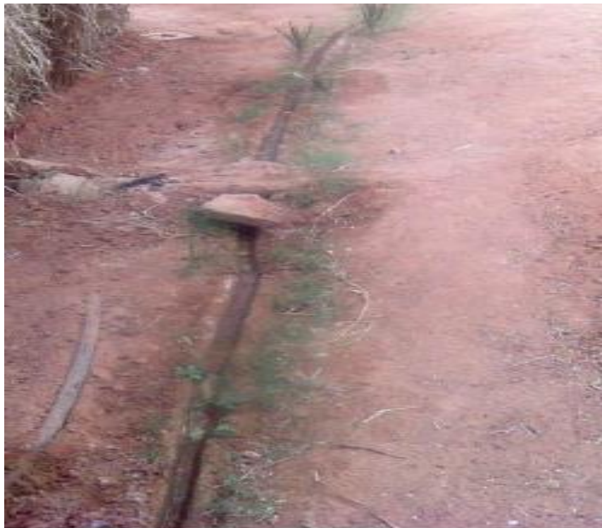
Fig: 22: Channel "Seguia"
